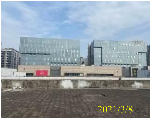
项目北面工业厂房
