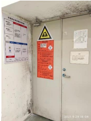
项目危险废物贮存场所标识
