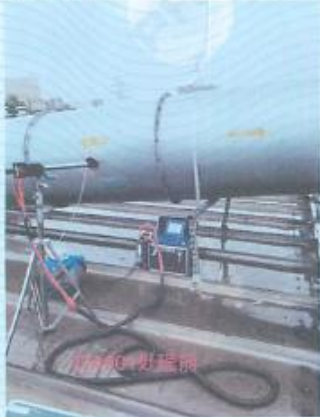
DA001 注塑废气处理前检测口 G7
